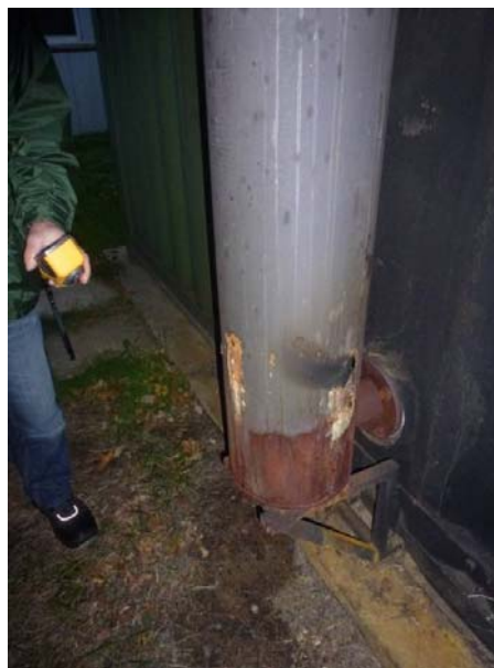
durchgerosteter Abgaskamin Auch hier: S \rightarrow H_2S \rightarrow H_2SO_4
